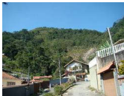
Foto 40 – Construções no caminho das águas.
