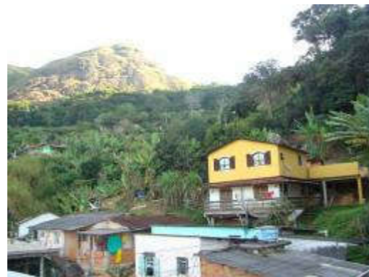
Foto 004 - Moradias construídas no talvegue.
