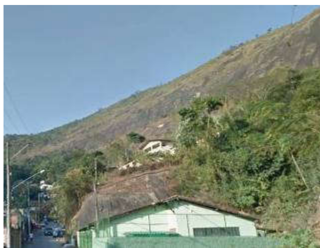
Foto 78 –Moradias no sopé do maciço rochoso.
