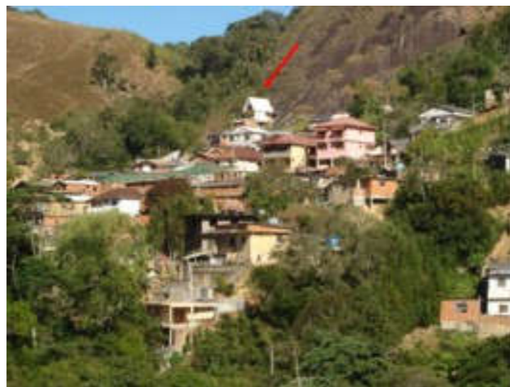
Foto 3.3 –Moradias implantadas na base do maciço rochoso.
