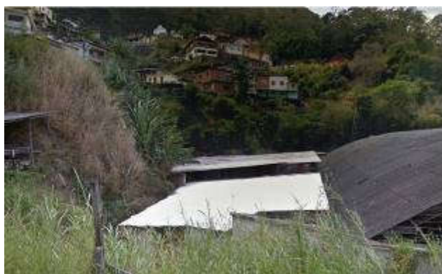
Foto 37 – Construções na linha de drenagem.
