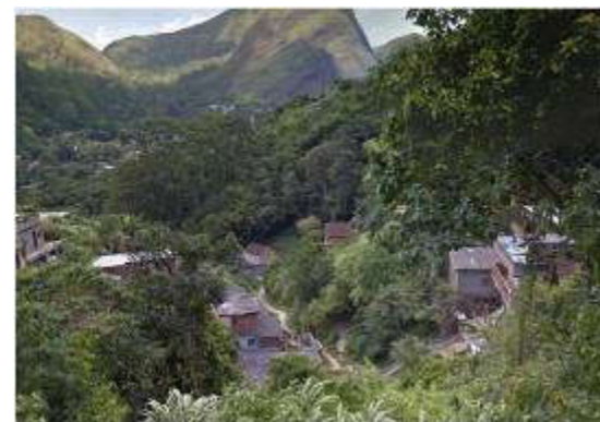
Foto 026 – Moradias na linha de drenagem.
