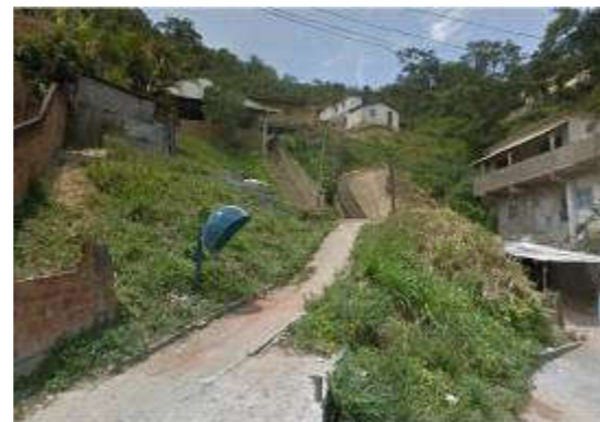
Foto 025 – Ocupação dentro do talvegue.
