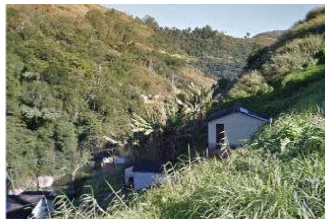
Foto 017 – Ocupação dentro da linha de drenagem.
