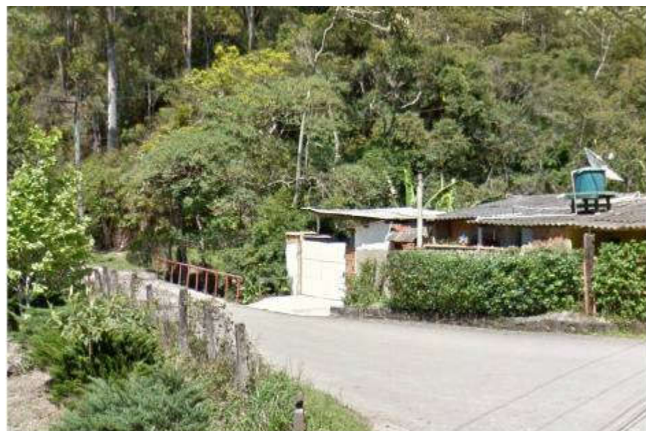
Foto 96 –Moradias dentro do caminho preferencial das águas.
