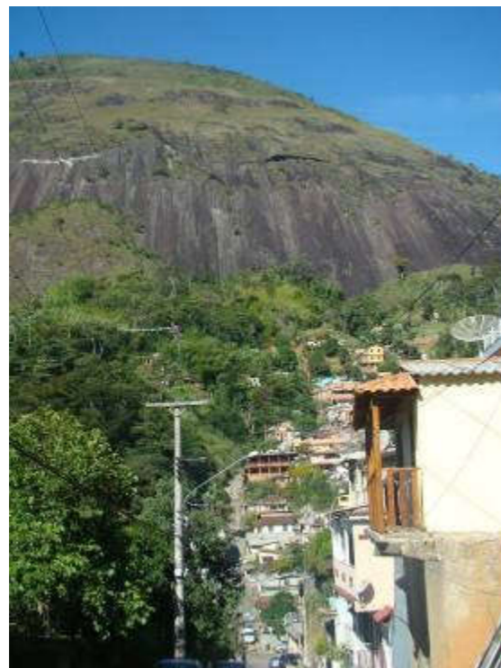
Foto 74 –Moradias implantadas sob maciço rochoso.
