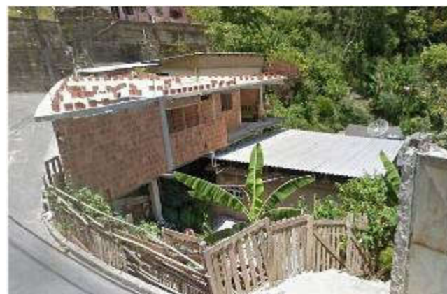
Foto 029 – Moradias no caminho preferencial das águas.
