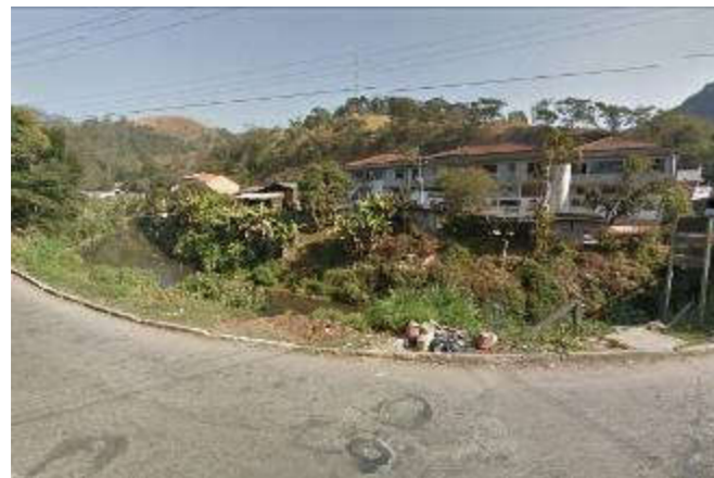
Foto 80 –Construções na faixa marginal.
