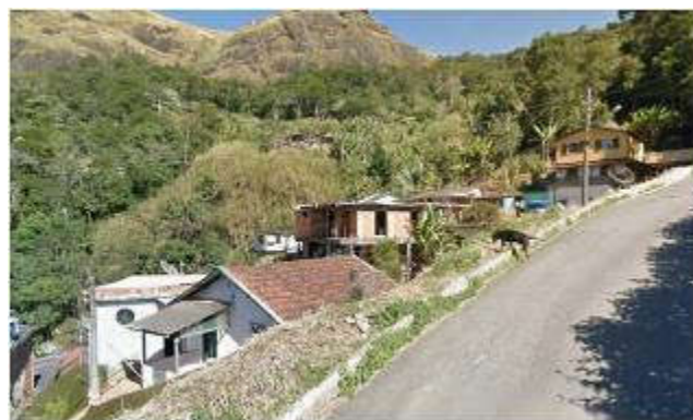
Foto 020 – Ocupações muito próximas à linha de drenagem.
