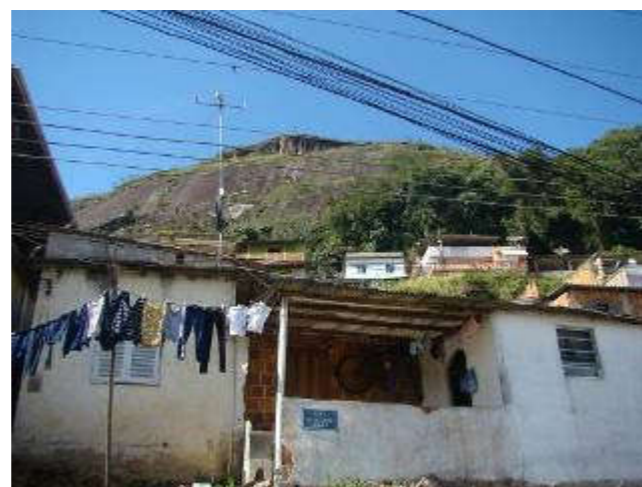
Foto 44 - Moradias sob o maciço rochoso.
