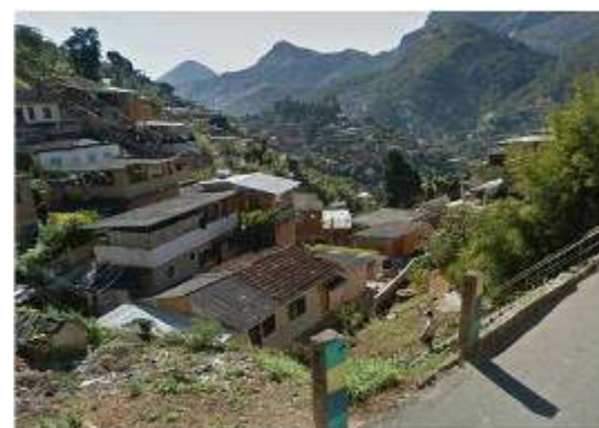
Foto 023 – Construções no caminho das águas.
