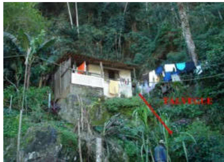
Foto 3.16 – Moradia construída no talvegue.
