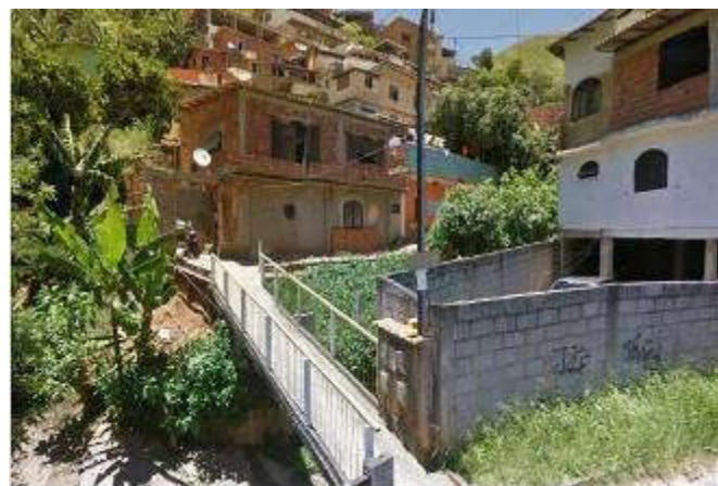
Foto 47 – Construções dentro da drenagem principal.
