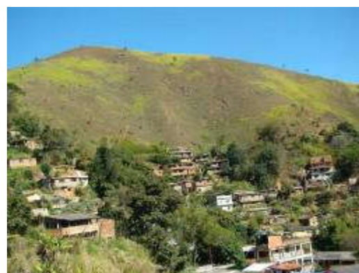
Foto 58 –Ocupação na linha de drenagem.
