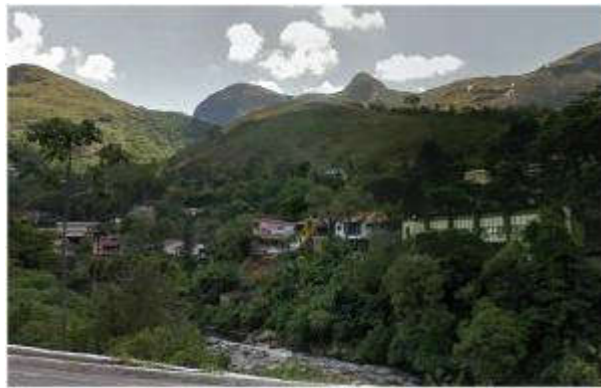
Foto 49 –Construções na faixa marginal.
