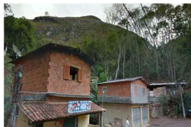
Foto 91 –Assentamento precário muito próximo ao maciço rochoso e à linha de drenagem.
