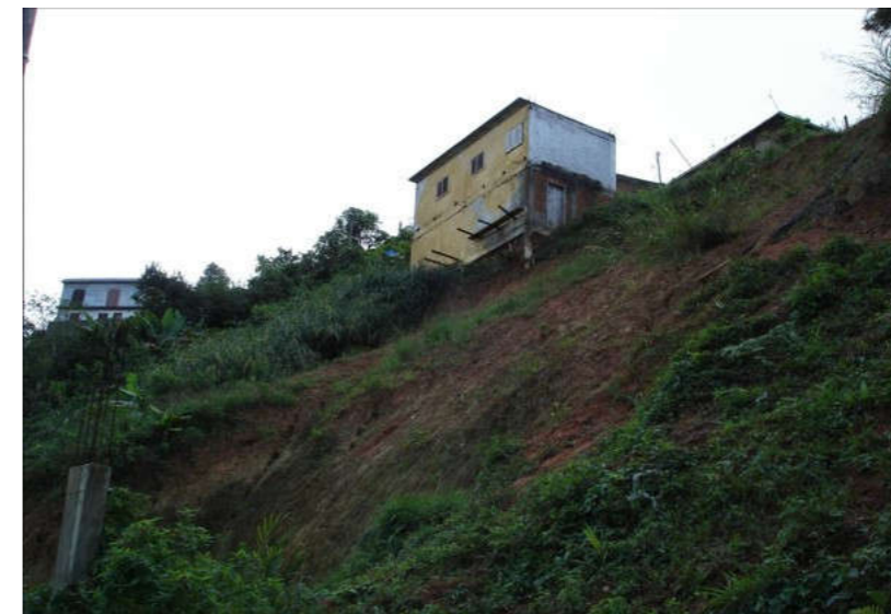
Foto 3.14 – Encosta muito íngreme – construção precária a montante
