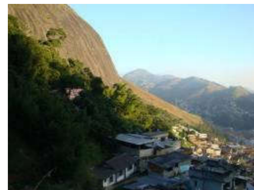
Foto 003 - Construções muito próximas ao maciço rochoso.
