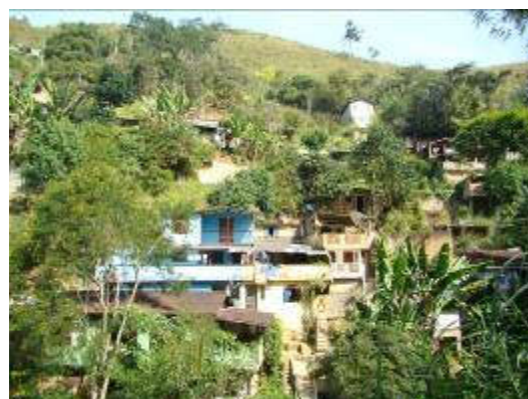
Foto 83 –Assentamento precário com deficiência de drenagem.
