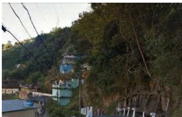
Foto 013 – Moradias muito próximas à linha de drenagem.
