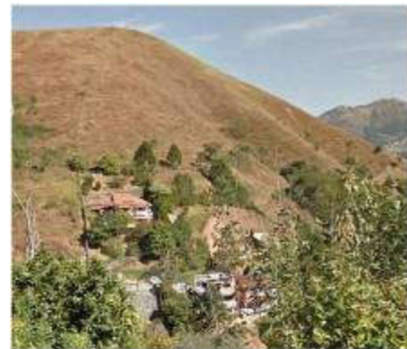
Foto 50 – Ocupação no sopé da encosta.
