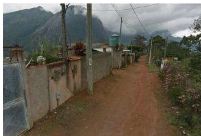
Foto 90 –Ocupação no topo do talude sem infraestrutura.
