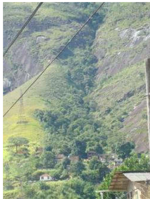
Foto 005 - Construções dentro da linha de drenagem natural.
