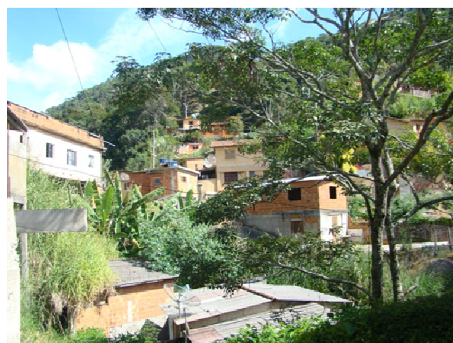
Foto 88 –Construções precárias a meia encosta e dentro do curso d'água.
