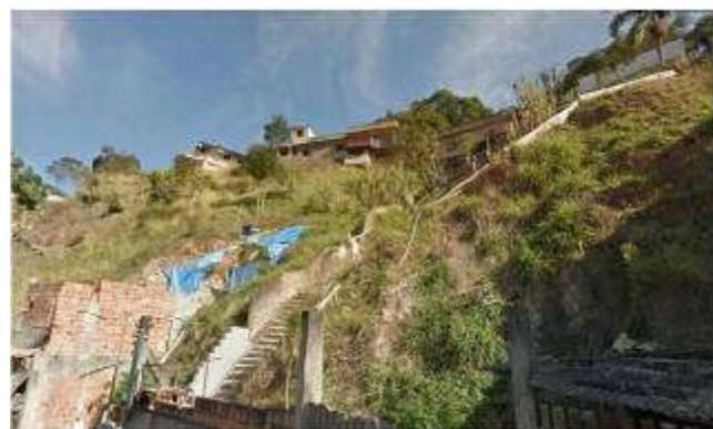
Foto 36 – Moradias a montante da encosta.
