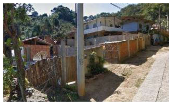
Foto 52 –Ausência de dispositivos de drenagem.
