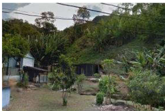
Foto 61 –Construções dentro do talvegue.
