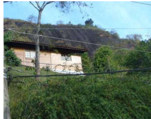
Foto 68 –Moradia implantada na base do maciço rochoso.
