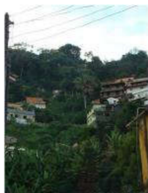
Foto 33 – Construções dentro do talvegue.
