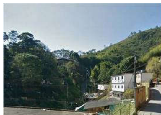
Foto 55 – Construções dentro da linha de drenagem.
