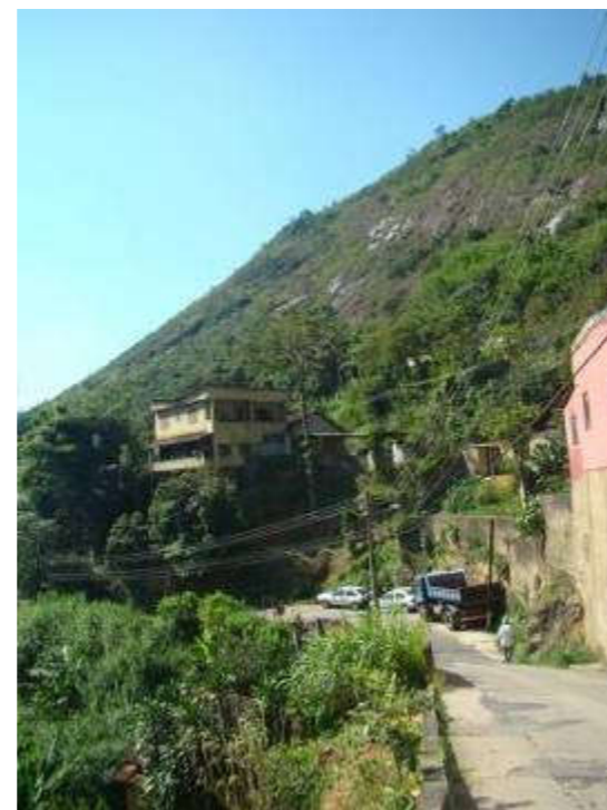
Foto 010 – Moradias implantadas na base do maciço rochoso.
