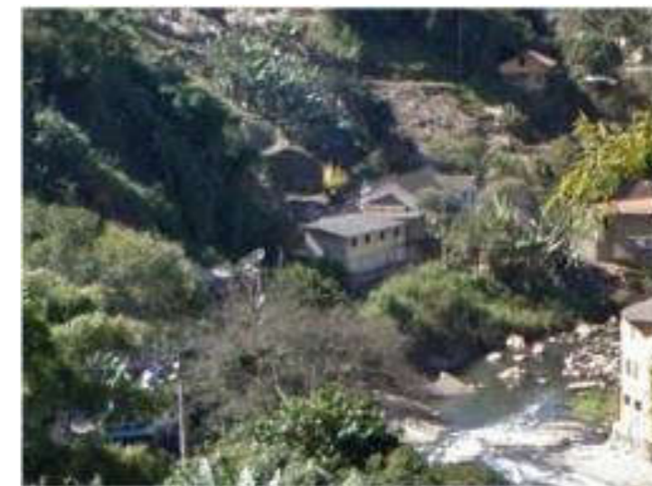
Foto 3.20 – Ocupação na margem do rio.
