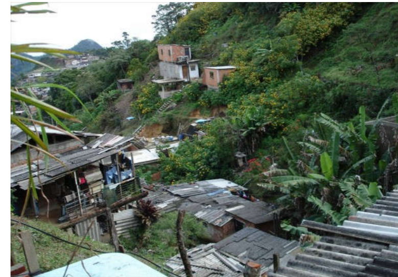
Foto 3.10 – Moradias muito precárias implantadas à meia encosta.
