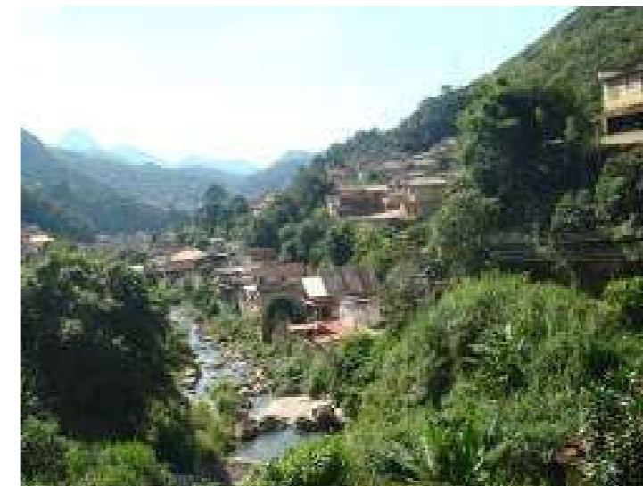
Foto 3.19 – Construções dentro do curso d'água.
