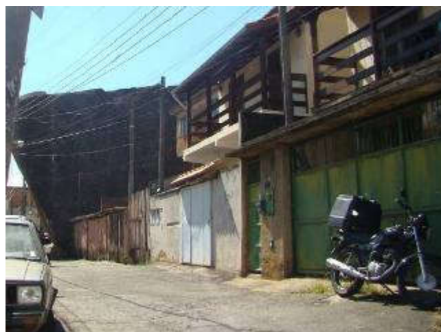
Foto 43 - Construções implantadas na área de depósito de blocos rochosos.
