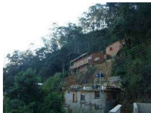
Foto 001 - Deficiência de drenagem e corte inadequado.
