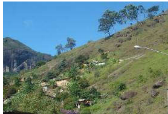
Foto 64 –Camada de solo sobre rocha e blocos soltos sobre as moradias.
