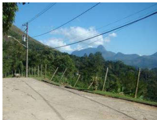
Foto 77 –Indícios de movimentação na encosta.
