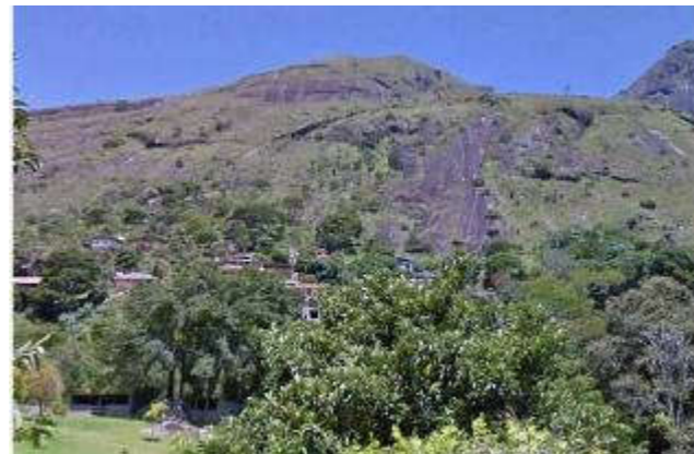
Foto 66 –Ocupação no sopé do maciço rochoso e nas linhas de drenagens.
