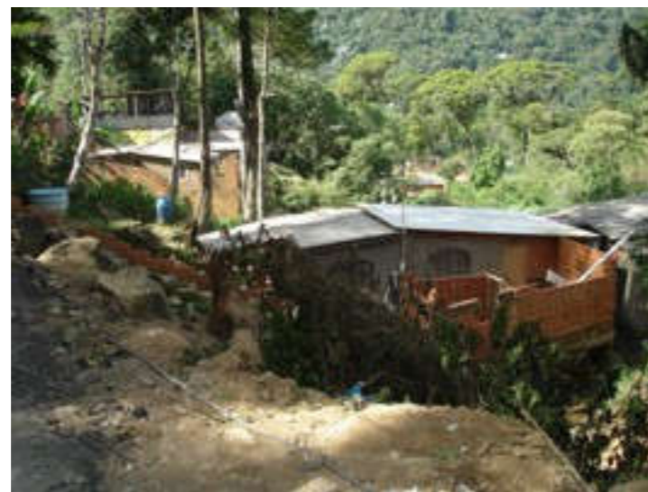
Foto 3.17 – Construções no caminho das águas.
